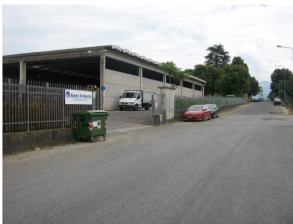
Foto 3 – Il capannone prefabbricato in c. a.
